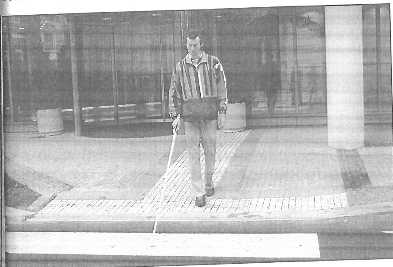
foto 4 Řešení signálních a varovných pásů v mozaice, pásy jsou lemovány deskami
